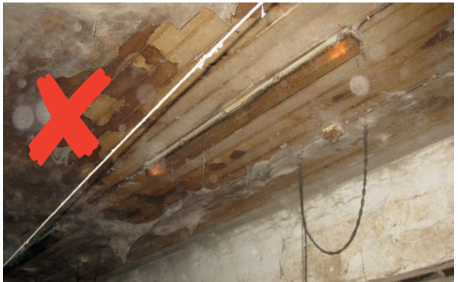
▲ Vilkkuva loisteputkivalaisin kuumentuu ja aiheuttaa vakavan paloriskin.
