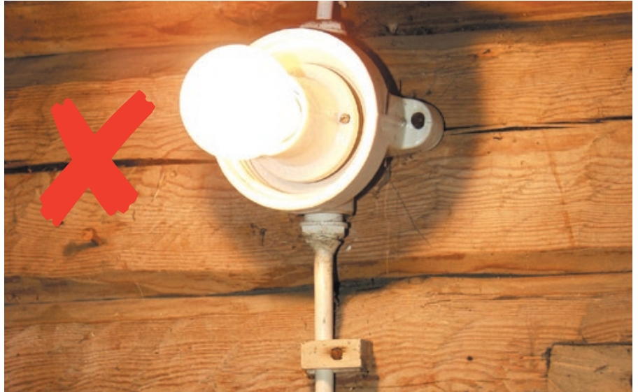
▲ Hehkulamppu ilman kupua on vaarallinen.
