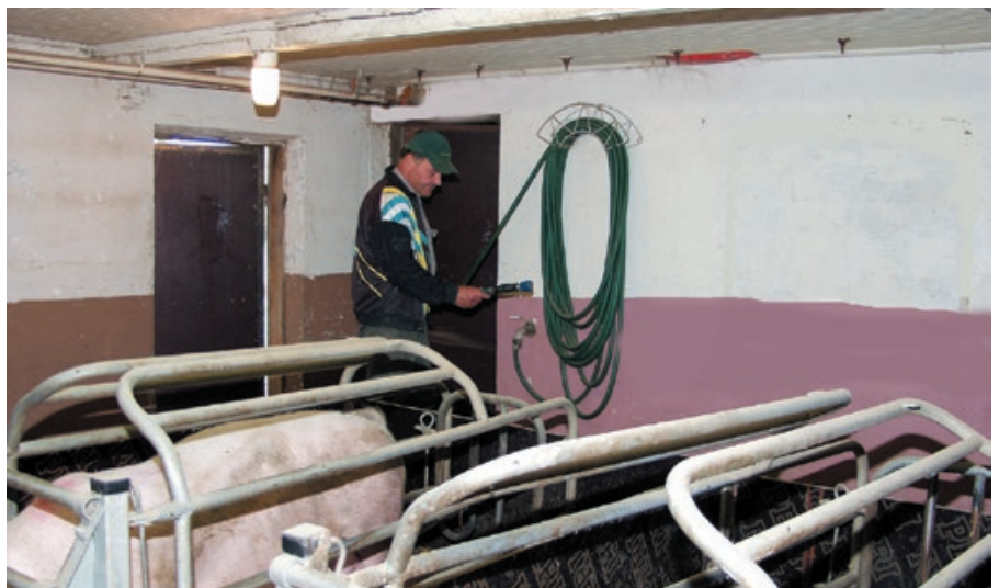
▲ Oven pielessä oleva tukeva vesiletku, jossa on suutin päässä, on hyvä alkusammutusväline, jos palo havaitaan heti sen syttyä.
