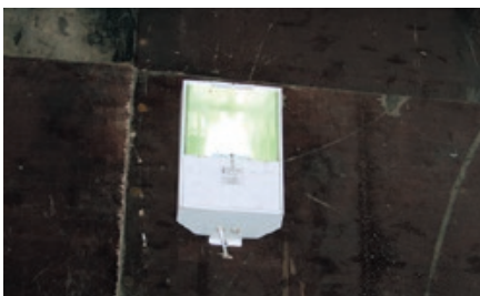
▲ Varastoon sopiva valaisin, jonka pintalämpötila ei ylitä sataa astetta.
