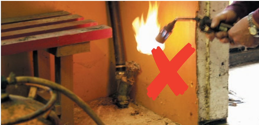
▲ Jäätynneen putken sulatus liekillä on aina kiellettyä.
