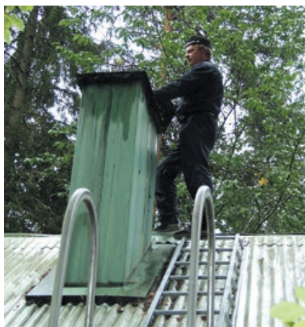
▲ Sotning av rökkanalerna i skorstenar är fortfarande en viktig del av sotningen.
