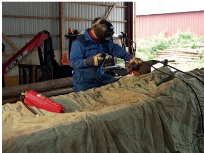
▲ Svetsning är tryggt när brandfarligt material skyddas med en våt obrännbar presenning. Två stora handbrandsläckare måste finnas nära till hands.
