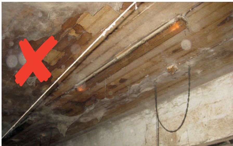
▲ Blinkande lysrörsarmaturer blir heta och orsakar allvarlig brandrisk.
