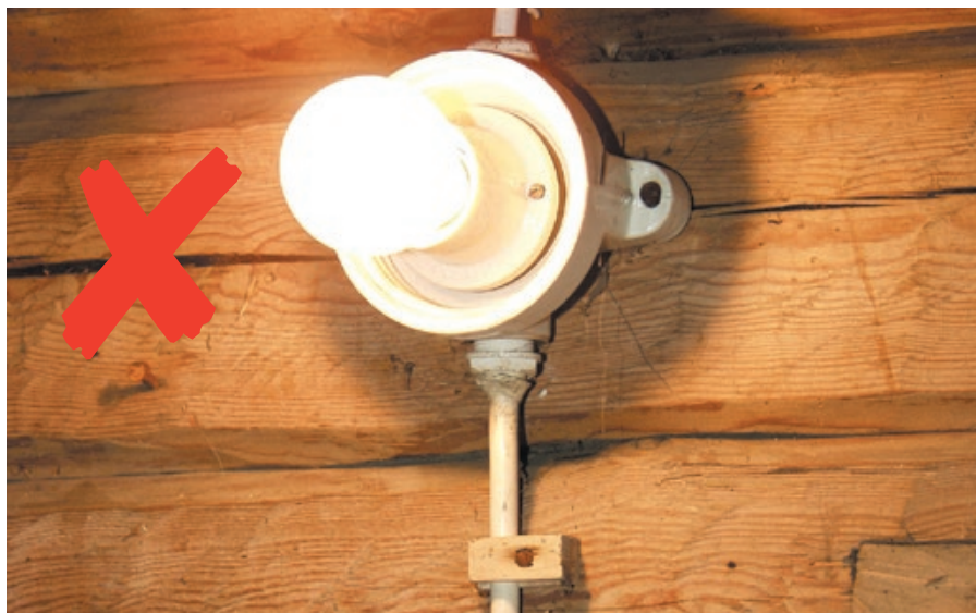
▲ En glödlampa som saknar kupa är farlig.
