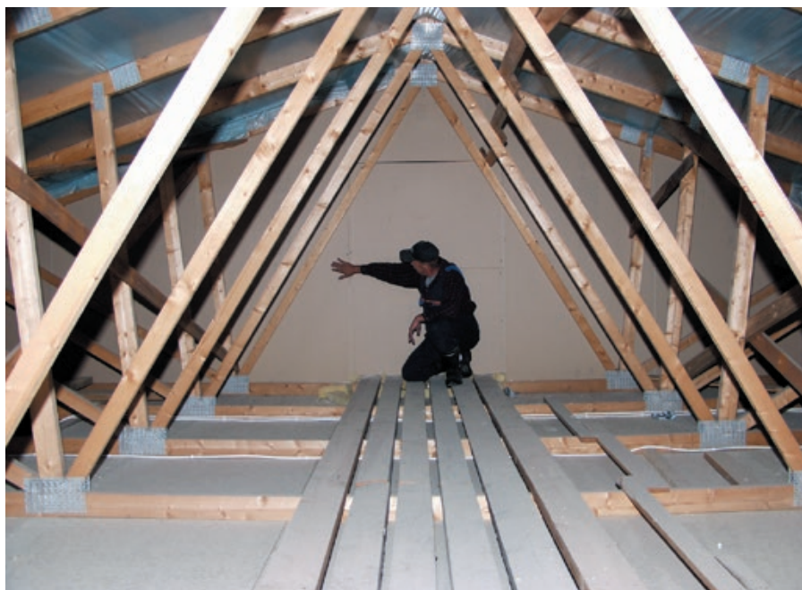
▲ I nya ladugårdar finns brandsektioner på vinden som hindrar en eventuell brand från att spridas snabbt till hela byggnaden.
