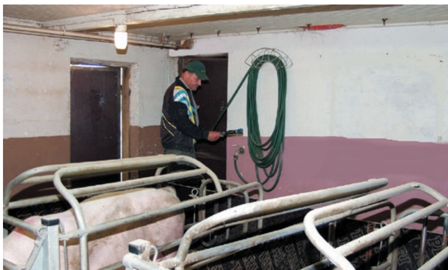
▲ En ordentlig vattenslang med munstycke som monterats vid dörrposten fungerar bra som handbrandsläckningsutrustning förutsatt att elden upptäcks genast då den kommit lös.
