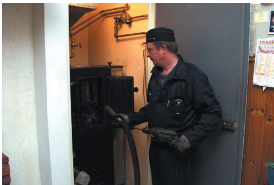
▲ Sotning av spis går snabbt och effektivt med ordentliga verktyg, visar Pekka Kähkönen som är distriktssotare i Vichtis.
